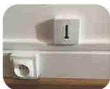
Le réseau cuivre a été massivement déployé dans les années 1970 pour nos téléphones fixes. Il permettait alors l'accès au seul réseau téléphonique commuté (RTC). Depuis les années 2000, il est également utilisé pour l'accès à internet haut débit (via les technologies ADSL, mais aussi SDSL et VDSL). La prise en forme de « T » inversé (voir photo ci-dessus) que vous avez peut-être chez vous est la terminaison de ce réseau cuivre.
